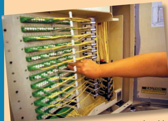
*Gabinete de distribución o "concentrador" típico de fibra. Debido a que no necesita electricidad, puede colocarse en cualquier lugar exterior.*
