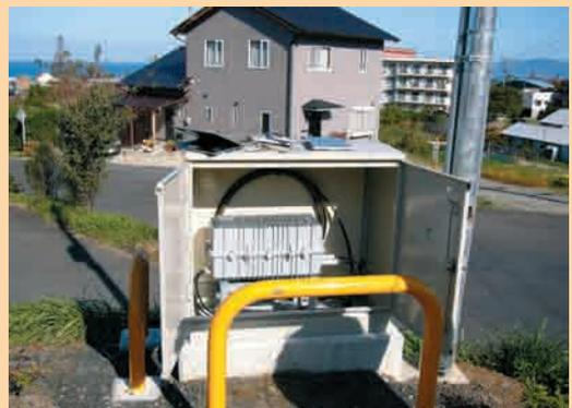
**Los pedestales y los Concentradores de Distribución de Fibra** más grandes son compartimentos cerca de la localidad del usuario. Éstos pueden sostener los divisores de la luz que lleva la señal de una fibra que se extiende hasta la oficina central, y la divide (típicamente de 8:1 hasta 32:1 pero tanto como 64:1) entre las fibras que llegan a las unidades de viviendas individuales.
